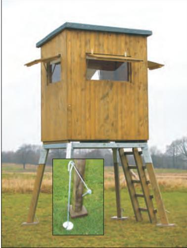
**Bockgerüst mit konischen Eckpfosten und Erdanker**
