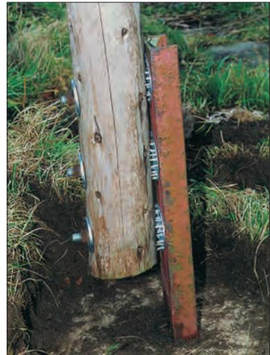
**Einbetonierte Winkel Eisen**
