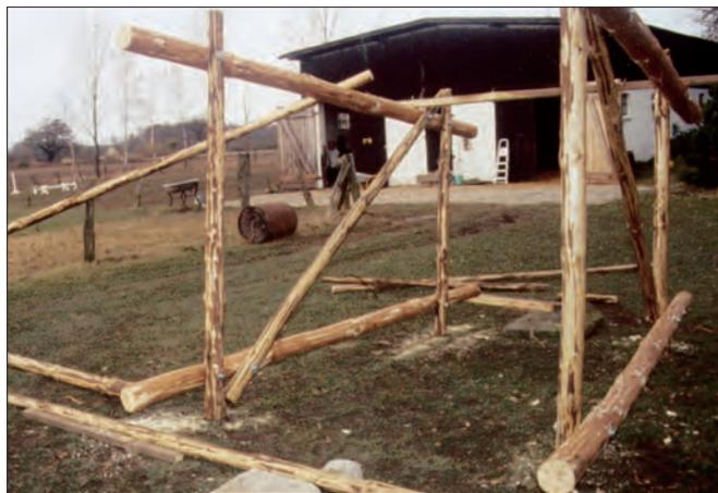
Nachdem 2 Seitenteile fertig montiert sind, werden sie seitlich aufgerichtet und mit Latten bzw. Stangen abgestützt. Mit Hilfe der rechtwinklig gespannten Schnur (s. Seite 17), werden auch diese Seitenteile ausgerichtet, so dass alle 4 Seiten des Bockgerüsts die gleiche Neigung haben. Danach können die Quer- und Diagonalstreben verschraubt werden. Bei Bockgerüsten
