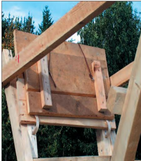
15. Um eine große Durchstiegöffnung zu erreichen, muss das Sitzbrett so weit wie möglich hochgeklappt und arretiert werden. Zuerst wird mittig im oberen Viertel der Rückenlehne ein Nagel eingeschlagen und auf der Rückseite umgebogen. Durch den Schlüsselring wird ein Stück Rollladenband durchgezogen und am umgebogenen Nagel eingehängt. Danach wird das Sitzbrett dann so weit wie möglich angehoben und das Rollladenband auf der Unterseite des Sitzbrettes befestigt.
