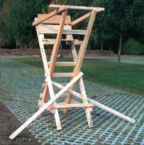
Diese kleine Ansitzleiter aus Schnittholz kann im Revier universell eingesetzt werden. Aufgrund der geringen Höhe ist aber bei der Auswahl des Aufstellungsortes auf einen geeigneten Kugelfang zu achten.
