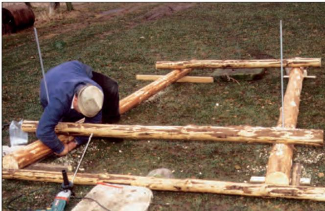
Die Verbindung der Hölzer erfolgt durch Verbolzen. Es werden Gewindestangen M 12 Güte 8.8, Bulldogdübel ( 50 mm und U - Scheiben 58/6 mm) verwendet. Die Gewindestangen werden durch die Bohrungen gesteckt und dann passend abgesägt. Die Bulldogdübel zwischen den Hölzern und die großen Unterlegscheiben unter den Muttern gewährleisten eine feste Verbindung.
