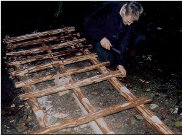
Für die Schraubverbindungen werden Gewindestangen M 8, Bulldogdübel und Unterlegscheiben nach DIN 1052 verwendet. Die Gewindestangen werden je nach Durchmesser der Stangen passend abgesägt.
