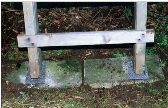
Betonplatten und Teerpappe schützen das Holz vor eindringender Feuchtigkeit von unten.
