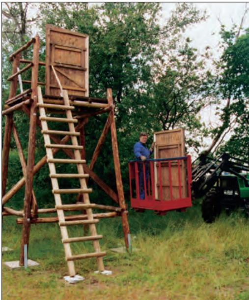
*Beim Aufstellen von Hochsitzen sind Schlepper (Teleskoplader), mit an dem Frontlader angebaute Arbeitsplattform, sehr hilfreich. In der Plattform hat man einen sicheren Arbeitsplatz und man kann Baumaterial bequem nach oben transportieren. Bei erhöht liegenden Arbeitsplätzen müssen Maßnahmen gegen Absturz getroffen werden, z.B. mit einem Sicherheitsgurt.*
